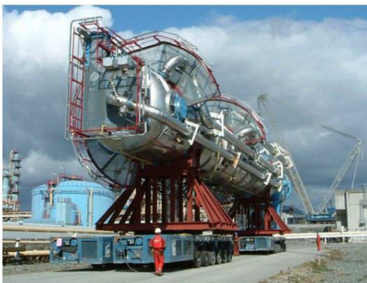
Figur 4-9: Bruk av SPMT, som frakter et ferdig utstyrt tårn – Referansebilde fra Kårstø.
