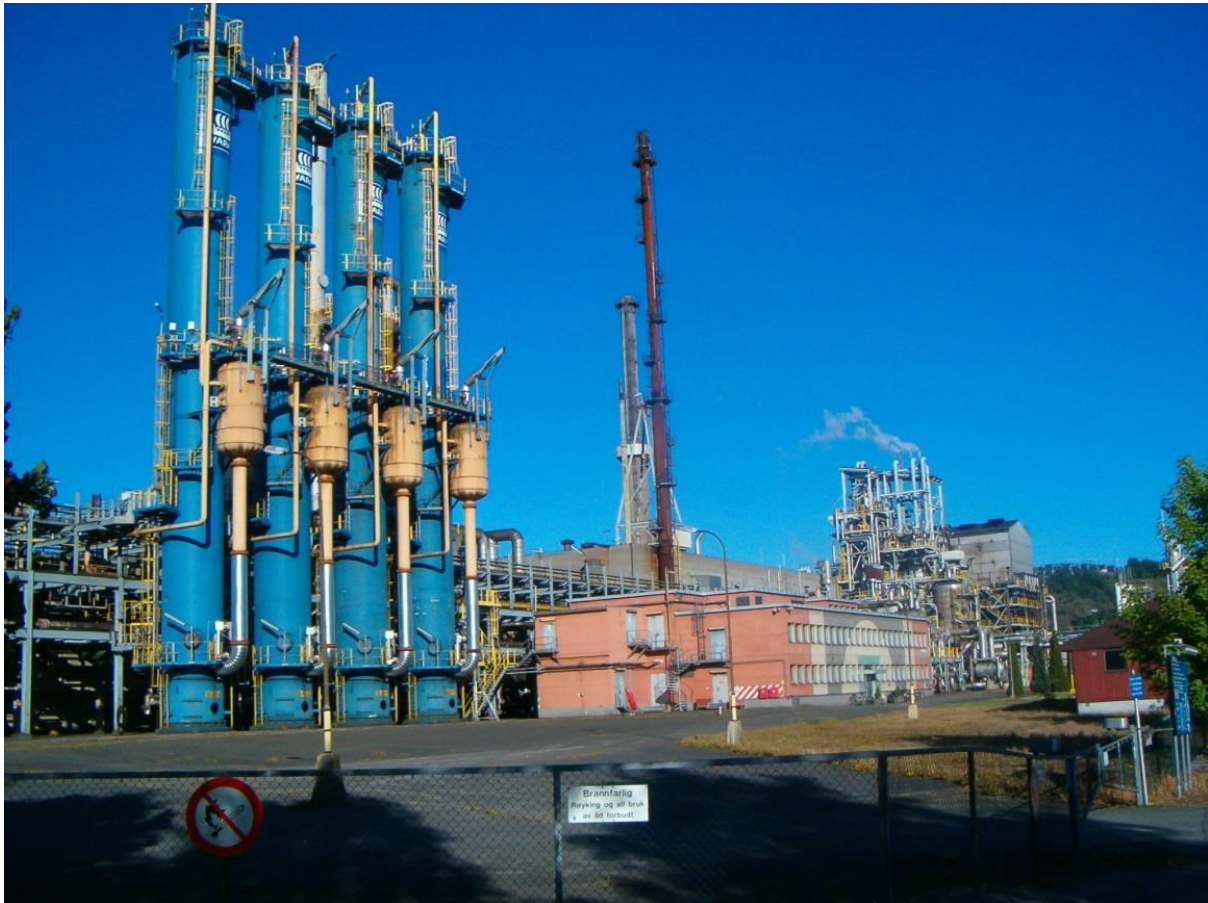
Figur 5.4.1 Ammoniakkfabrikk N2 i Porsgrunn. I forgrunnen fire vannvasktårn der CO 2 fjernes fra prosessgassen.
